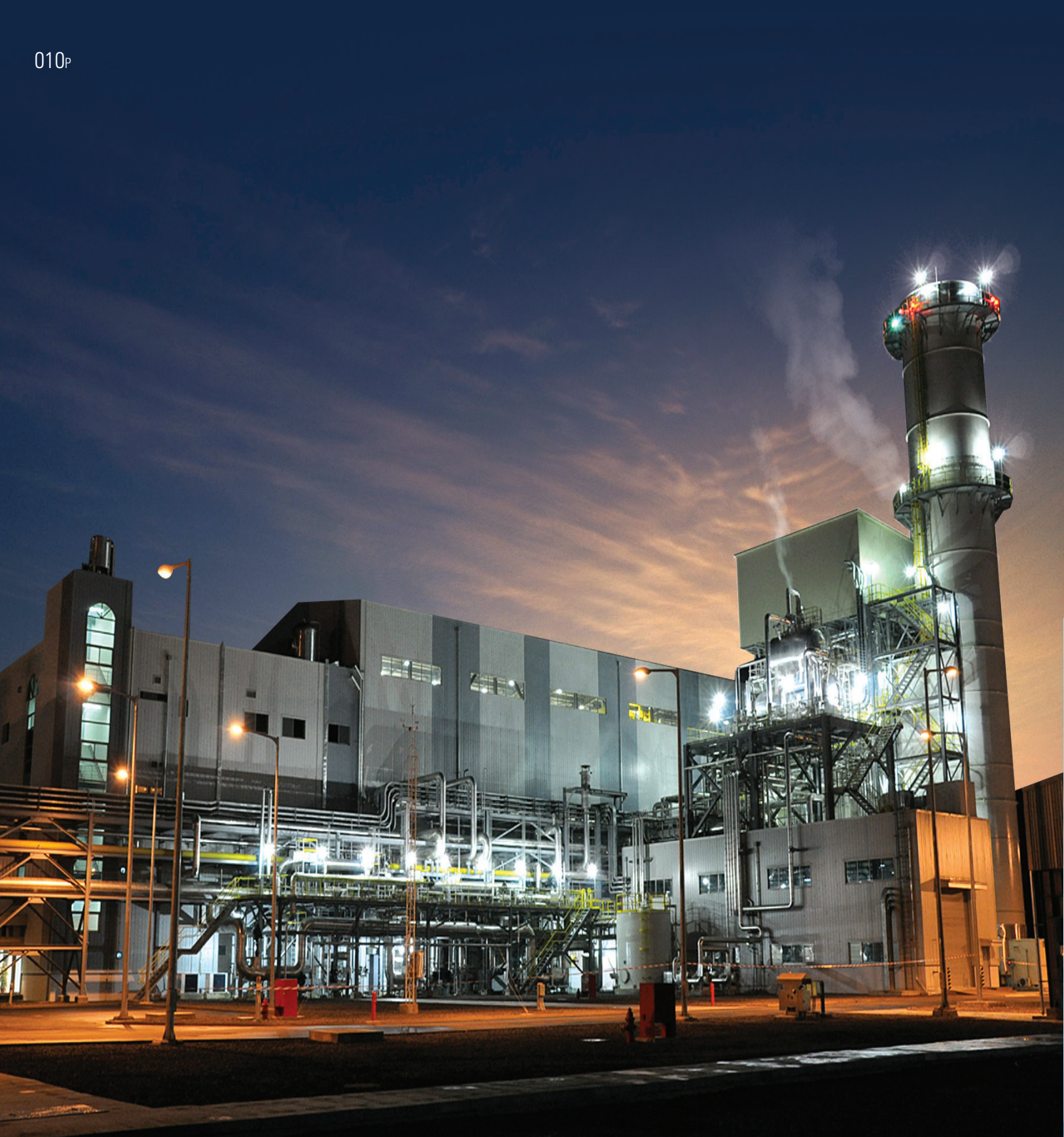
010P Yerevan Combined Cycle Power Plant 위치: Yerevan, Armenia - 복합화력발전: 230MW - 가스터빈(167MW×1) - 스팀터빈(63MW×1) 공사기간: 2007. 12 ~ 2010. 04
